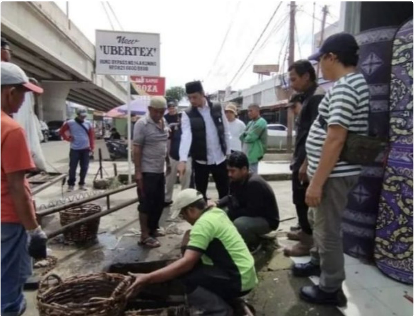
Pemko Bukittinggi Gotong Royong Bersihkan Drainase Pasar Aur Kuning
